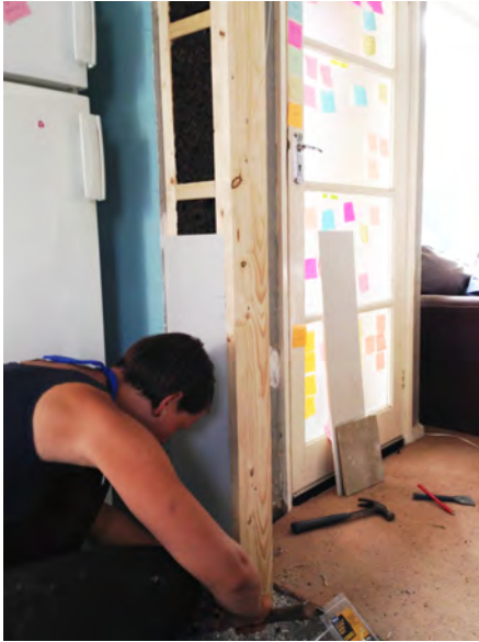
Cork insulation & old plasterboard in mini stud
