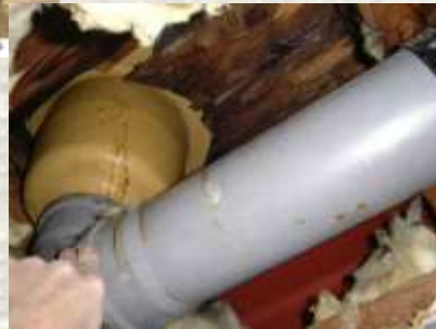
Abb. 4: Beispiel: Öffnung des Daches zur Vermeidung von Feuchteintritten in der Schalung des 1. Stockes
