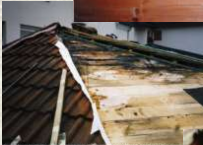
Abb. 4: Beispiel: Öffnung des Daches zur Vermeidung von Feuchteintritten in der Schalung des 1. Stockes
