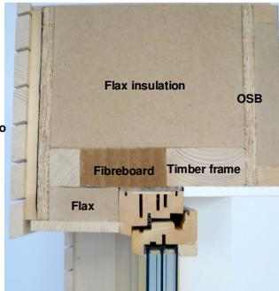
Sigg window installation detailing. See [www.passivhausfenster.at](http://www.passivhausfenster.at)
